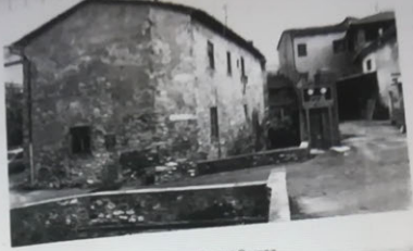
Novembre 1983. Il primo gruppo di edifici sul Gorone.
